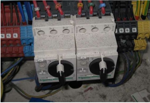
Şalter üzerinde kir, tabanda açıklık
