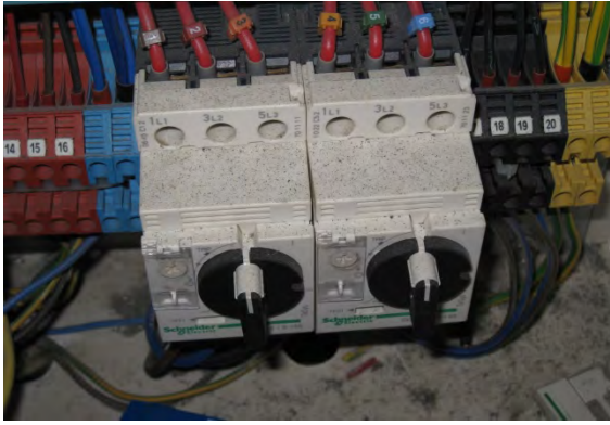
Şalter üzerinde kir, tabanda açıklık
